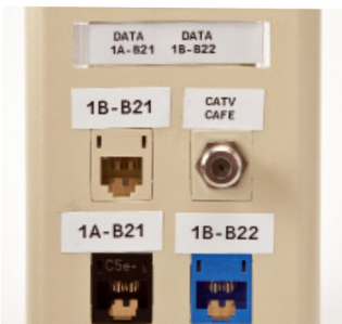
Oznaczenia płyt czołowych i otworów wylotowych
